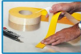
Die Schutzfolie abziehen. Einen Rand Korrekt anlegen und dann das restliche selbstklebende Band entrollen und dabei darauf achten, dass sich keine Lufteinschlüsse unter dem TBS bilden. Mit einer Hartgummirolle das TBS-Band einige Sekunden auf die Fläche drücken und eventuell vorhandene Lufteinschlüsse ausrollen.
